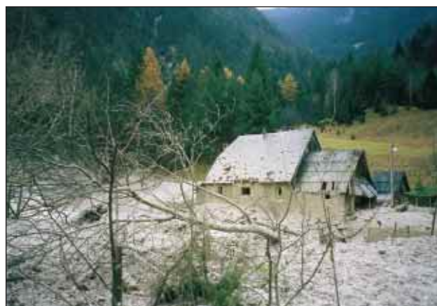
Slika 10. Hiša nad koriti na levem bregu Predelice je drobirski tok samo oplazil, obstala je zaradi trdne kamnite podlage, na kateri je zgrajena (19. november 2000) (foto: B. Komac)
