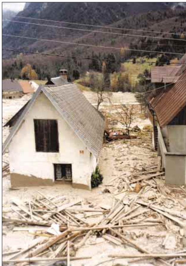
Slika 15. Razdejanje, ki ga je povzročil drobirski tok v zgornjem delu vasi Log pod Mangartom (foto: B. Ušeničnik) Figure 15. Devastation caused by the debris flow in upper Log pod Mangartom (photo: B. Ušeničnik)
