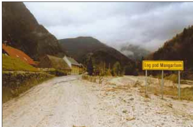
Slika 17. Naplavina gramoza na cesti ob vhodu v Log pod Mangartom, kjer je drobirski tok pljusnil čez cesto (foto: B. Ušeničnik) Figure 17. Deposited gravel on the entry road to Log pod Mangartom, where the debris flow slid across the road (photo: B. Ušeničnik)
