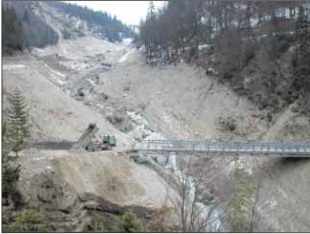
Slika 29. Čiščenje spodnjega dela mangartske ceste (foto: B. Ušeničnik) Figure 29. Clearing the bottom part of the Mangart road (photo: B. Ušeničnik)
