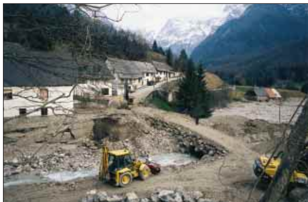
Slika 25. Zasilni most čez Predelico v zgornjem Logu pod Mangartom (foto: B. Ušeničnik) Figure 25. Provisional bridge across the Predelica stream in upper Log pod Mangartom (photo: B. Ušeničnik)
