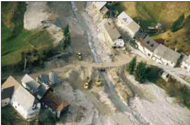
Slika 30. Usmerjanje struge Predelice v Logu pod Mangartom (foto: B. Ušeničnik) Figure 30. Redirecting the watercourse of the Predelica stream in the area of upper Log pod Mangartom (photo: B. Ušeničnik)
