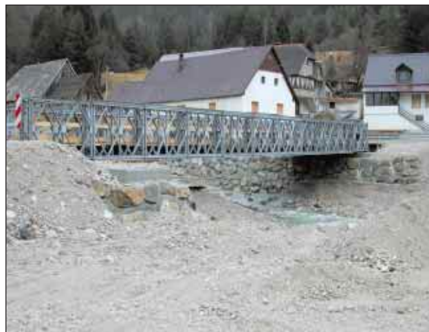
Slika 26. Nadomestni montažni most čez Predelico v zgornjem delu vasi Log pod Mangartom (foto: B. Ušeničnik) Figure 26. Substitute bridge across the Predelica stream in upper Log pod Mangartom (photo: B. Ušeničnik)
