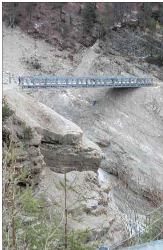
Slika 27. Nadomestni montažni most čez Mangartski potok na cesti proti Predelu (foto: B. Ušeničnik) Figure 27. Substitute bridge across the Mangart stream on the road towards Predel (photo: B. Ušeničnik)
