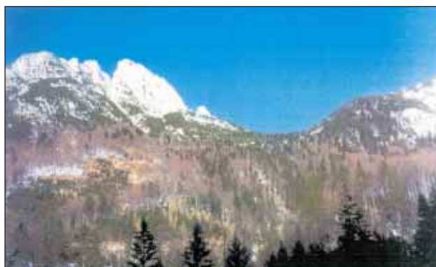
Slika 9. Pogled na pobočje pod Stožami pred plazovi (foto arhiv: I. Mlekuž) Figure 9. View of the slope below Stože before the landslides (photo archives: I. Mlekuž)
