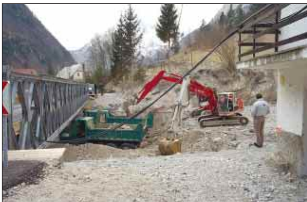
Slika 4. Interventno čiščenje struge Predelice (foto: D. Durjava)
