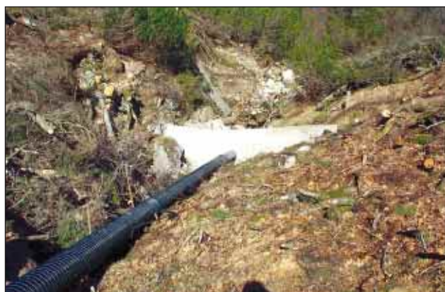
Slika 7. Odvodnjavanje zalednih voda nad plaziščem – za- jem hudourniških pritokov Mangartskega potoka (foto: D. Durjava) Figure 7. Draining of water on the upper side of the land- slide – the torrential tributaries of Mangartski potok (photo: D. Durjava)
