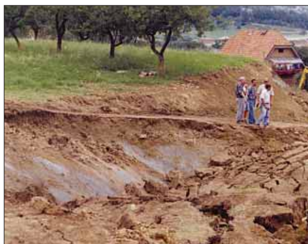
Slika 5. Gibanje zemljine v zemeljskem plazov (5a). Rjava zemljina, glinasti melj s peskom drsi po mastni glini. Posnetek iz vkopa na AC Arja vas-Vransko. Na sliki 5b je bližnji posnetek drsne ploskve. V prikazanem primeru je rekonstrukcija plazov in določitev materialnih parametrov zemljin v kritičnem območju enostavna. Pri večini plazov pa so v drsni ploskvi zemljine premešane, pregnetene in zelo heterogene, zato je preiskovanje in določanje strižnih parametrov pogosto zelo težavno. (foto: A. Petkovšek)
