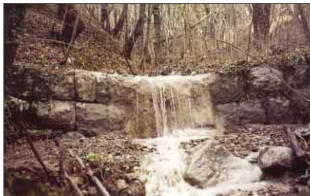
Slika 2. Obrambne zidove v koritu Grajščeka je zgradila avstrijska oblast leta 1903. Fotografirano 30. decembra 2000 (foto: M. Kovač)
