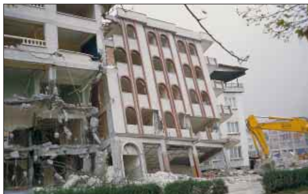
Slika 3. Potres 17. avgusta 1999 z žariščem ob Izmitskem zalivu na severozahodu Turčije je zahteval 17.840 življenj. Stanovanjski objekt v Adapazarju se je zaradi slabih geoloških razmer nagnil. (foto: R. Vidrih)
