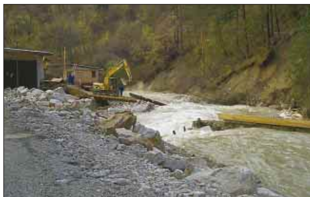
Slika 2. Tržiška Bistrica – poškodovan jez pri Tokosu (foto: P. Pejakov) Figure 2. Tržiška Bistrica – a damaged dam by the Toko factory (photo: P. Pejakov)
