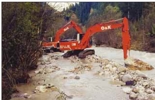
Slika 5. Odstranjevanje naplavin iz Savinje med Robanovim kotom in Presihajočim studencem (foto: T. Jeršič) Figure 5. Removal of deposits from the Savinja riverbed on the section between Robanov kot and Presihajoči studenec (photo: T. Jeršič)
