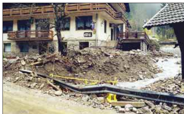
Slika 11. Interventno vzpostavljanje pretočnega profila hudournika Lašek (foto: T. Jeršič) Figure 11. Intervention measures – restoration of the flow cross section (photo: T. Jeršič)
