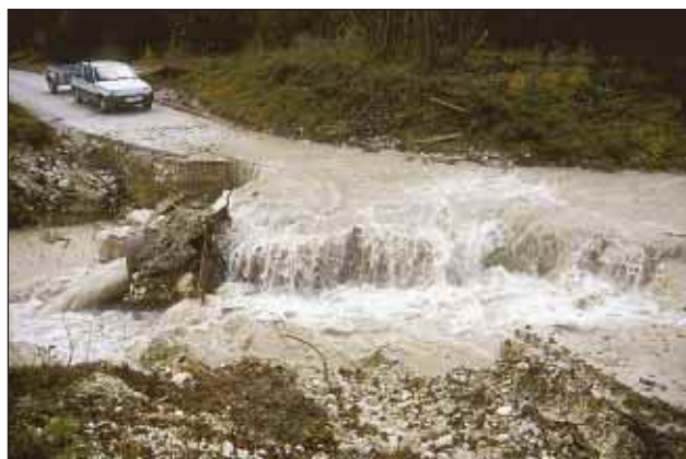
Slika 1. Radovna – odnešena mulda (foto: A. Klabus) Figure 1. Radovna – a ruined road (photo: A. Klabus)
