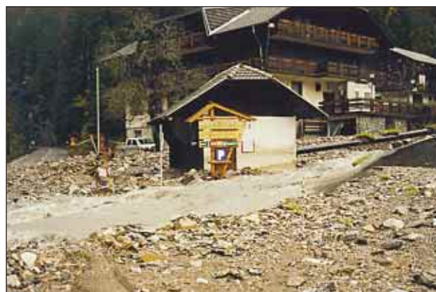
Slika 12. Izlivni odsek hudournika Lašek (foto: T. Jeršič) Figure 12. Outflow of the Lašek torrent (photo: T. Jeršič)
