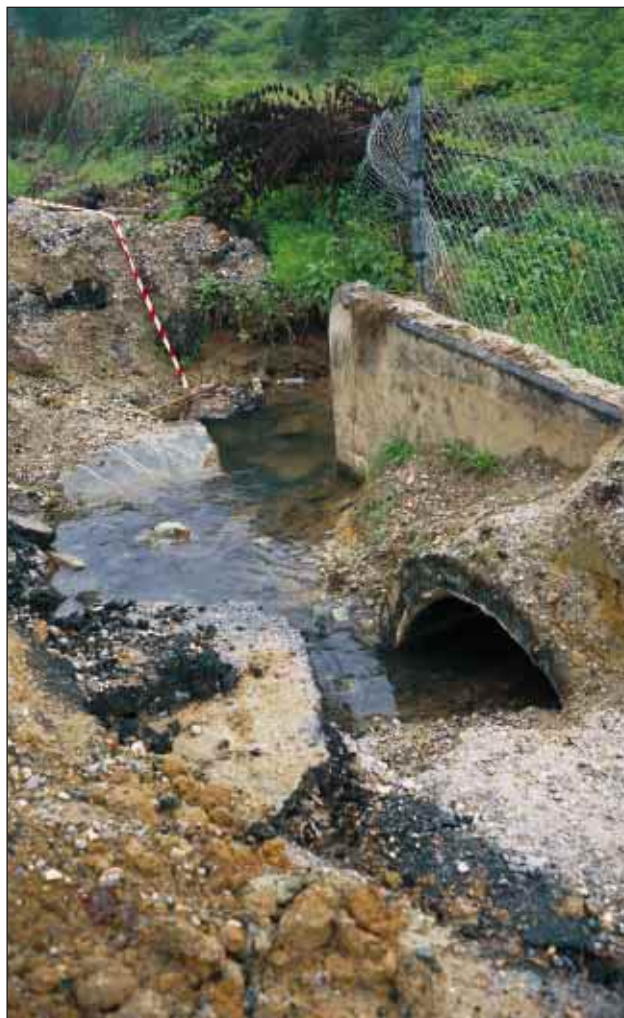
Slika 20. Zamik kanalizacijske cevi za 3,5 m. (foto: R. Vidrih) Figure 20. Displacement of a drainage system pipe by 3.5 m. (photo: R. Vidrih)
