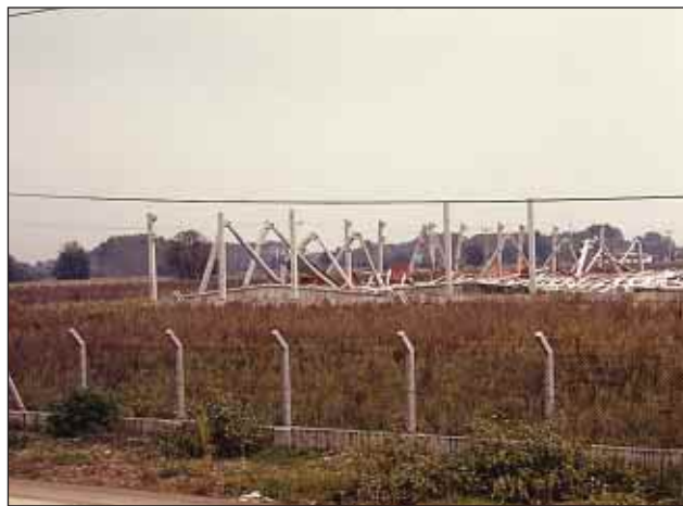
Slika 10. Tudi porušitev nove industrijske hale v Adapazarju je posledica slabih geoloških pogojev. (foto: M. Godec)
