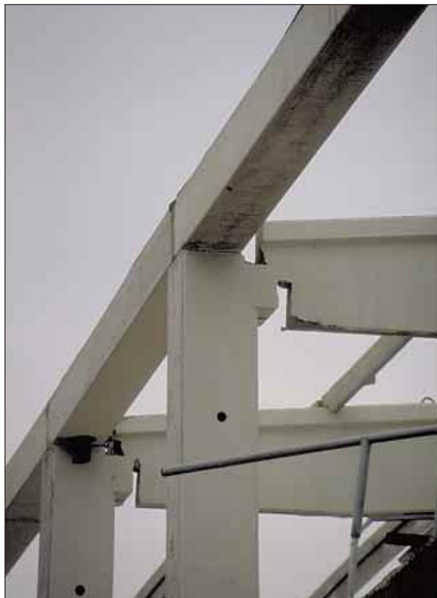
Slika 7. Stiki strešnih nosilcev in stebrov montažne hale na robu porušitve (foto: M. Fischinger)
