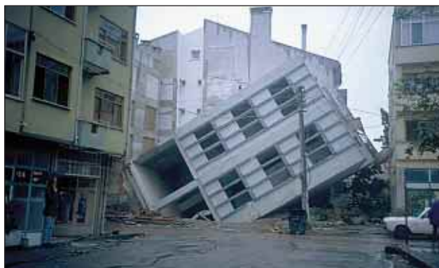
Slika 3. Porušitev zaradi utekočinjenja tal (foto: P. Fajfar) Figure 3. Collapse due to liquefaction (photo: P. Fajfar)
