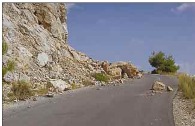
Slika 10. Na cesti med krajema Aspropyrgos in Fili so na cesto zgrmeli številni kamninski podori Figure 10. Rockfall on the road from Aspropyrgos to Fili
