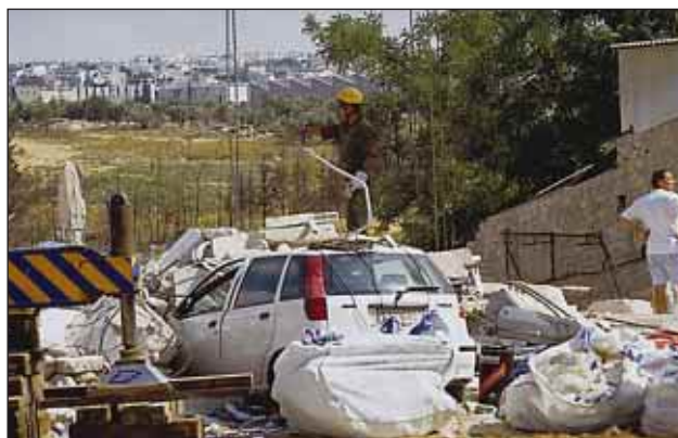
Slika 9. Podrta garaža v neposredni bližini tovarne »Ricomex« Figure 9. Damaged garage near the »Ricomex« factory
