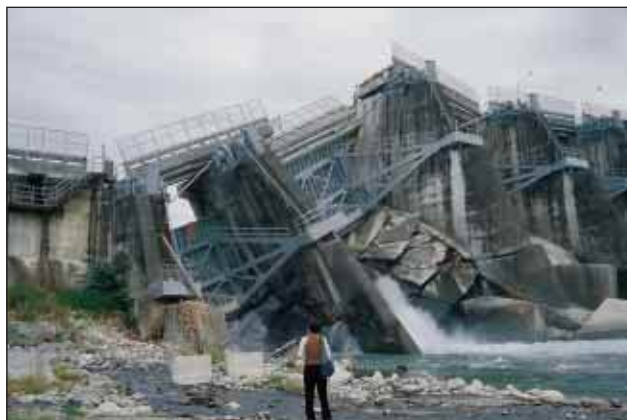
Slika 11. Na prelomu je bila postavljena pregrada Ši-Gang, ki se je zaradi površinskega pretrga porušila. Na eni strani preloma je prišlo do dviga 3–4 m, na drugi pa do pogreznitve 1–2 m (foto: R. Vidrih)
