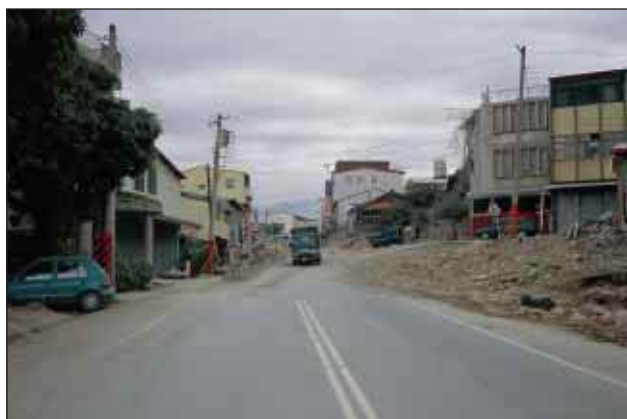
Slika 13. V posameznih naseljih je pretrg potekal po ulicah, ponekod celo pod hišami. Ena stran ulice se je dvignila nad drugo (foto: R. Vidrih)
