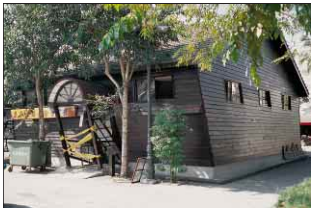
Slika 8. Lesene zgradbe se ob močnem potresu lahko zelo deformirajo, porušijo pa ne. Primer na sliki kaže železniško postajo (foto: R. Vidrih)
