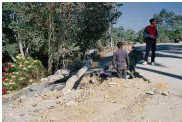
Slika 14. Zaradi plazjenja, ki ga je povzročil potres, je prišlo do deformacije cestišča (foto: R. Vidrih)
