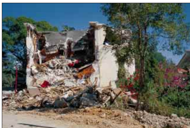
Slika 16. Popolnoma porušena stanovanjska zgradba (foto: R. Vidrih)
