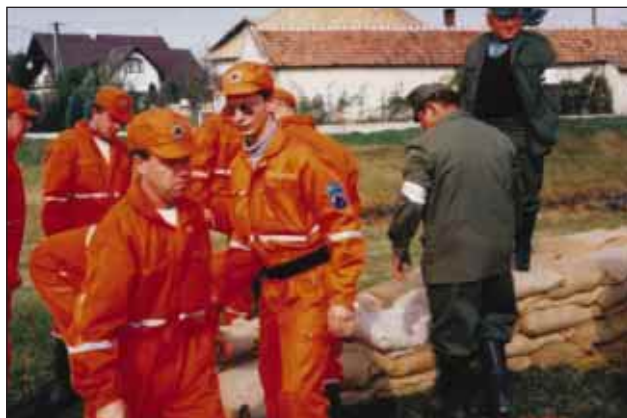
Slika 10. Prikaz gradnje obrambnega nasipa iz vreč, napoljenih s peskom; Csesztreg, 7. 10. 1997 (foto: J. Bošnjak) Figure 10. Construction of a dike of sandbags; Csesztreg, 7 October 1997 (photo: J. Bošnjak)
