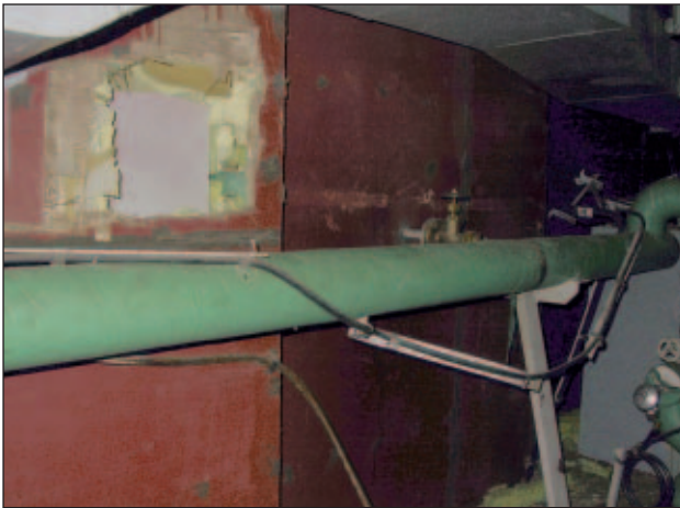
Slika 8. Odstranjevanje obloge v skladišču št. 1 je bilo zaradi raznih instalacij izredno težko in nevarno delo. (foto: A. Bubnič)
