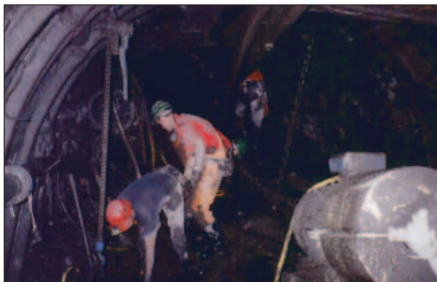
Slika 2. Nakladanje vdornega materiala na verižni transporter na koti 86 (foto: I. Kenda)
