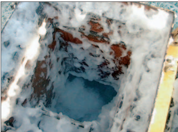
Slika 9. Skladišče št. 2, napolnjeno s peno, neposredno pred vstopanjem ekip v podkrovje (foto: B. Koprivec)
