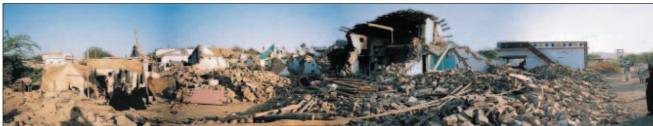
Slika 19. Pogosto so zgradbe zgrajene iz neobdelanega kamna, povezanega s slabo malto. Posledica močnega potresa pri takšnih zgradbah je porušitev objekta in opustošenje mest in vasi.
