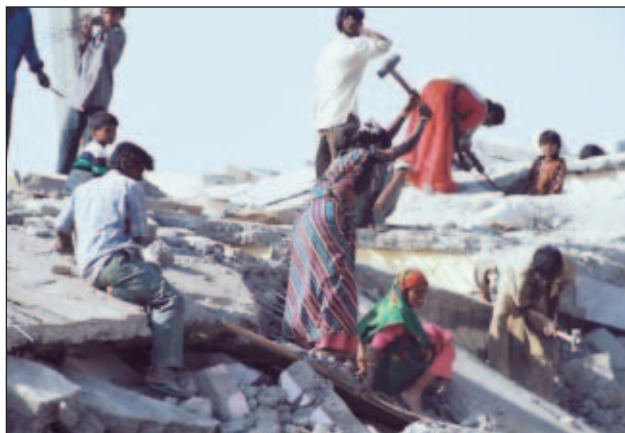
Slika 16. V Bhuju so se nekateri novejši armiranobetonski okviri sesedli. Življenje pa teče dalje. Po potresu so se še med ruševinami takoj odprle »trgovine«.
