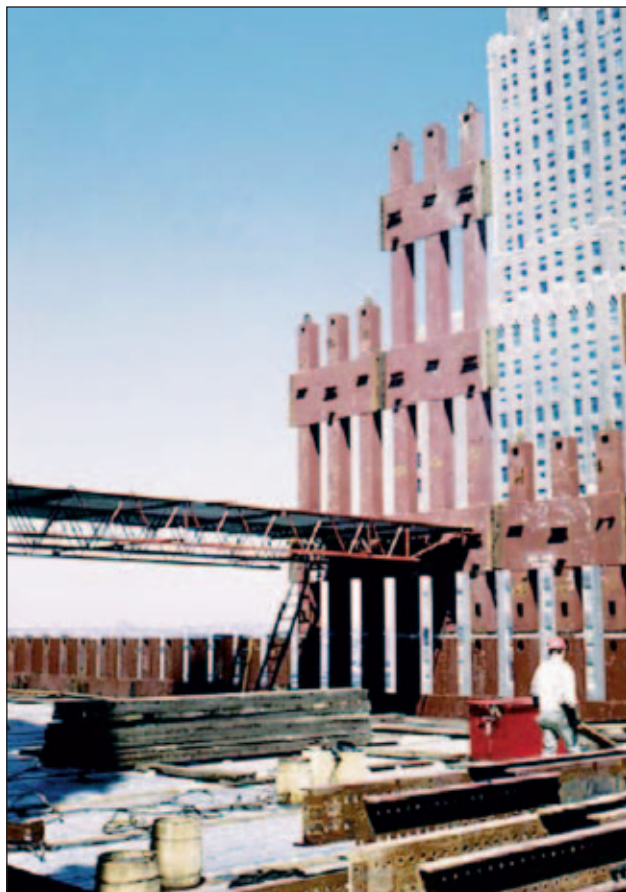
Slika 6. Gradnja stropne konstrukcije (poročilo ASCE in FEMA)
