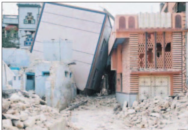
Slika 11. Novejša konstrukcija na levi se je med potresom prevrnila, zgradba na desni pa je prestala tudi potres leta 1956.
