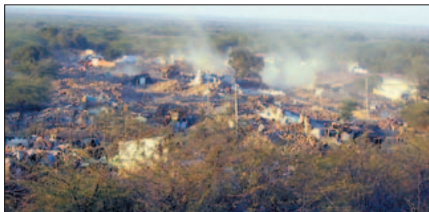
Slika 17. Jhurand. Skoraj vse zgradbe v mestu so se zrušile v povezan kup grobih kamnitih kosov. Prah, ki je viden na sliki, je posledica čiščenja. Slika je bila posneta približno dva tedna po potresu.
