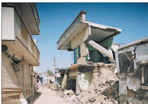
Slika 13. Bhuj. Najbolj so bile prizadete zgradbe, zgrajene iz različnih materialov. Sorazmerno nov objekt je imel stene iz kamna, deloma armiranega betona, ponekod pa armiranobetonske plošče.
