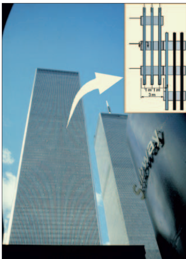
Slika 5. Zunanji nosilni ovoj. Slika fasade (foto: M. Fischinger) in detajl montažnega elementa (poročilo ASCE in FEMA)
