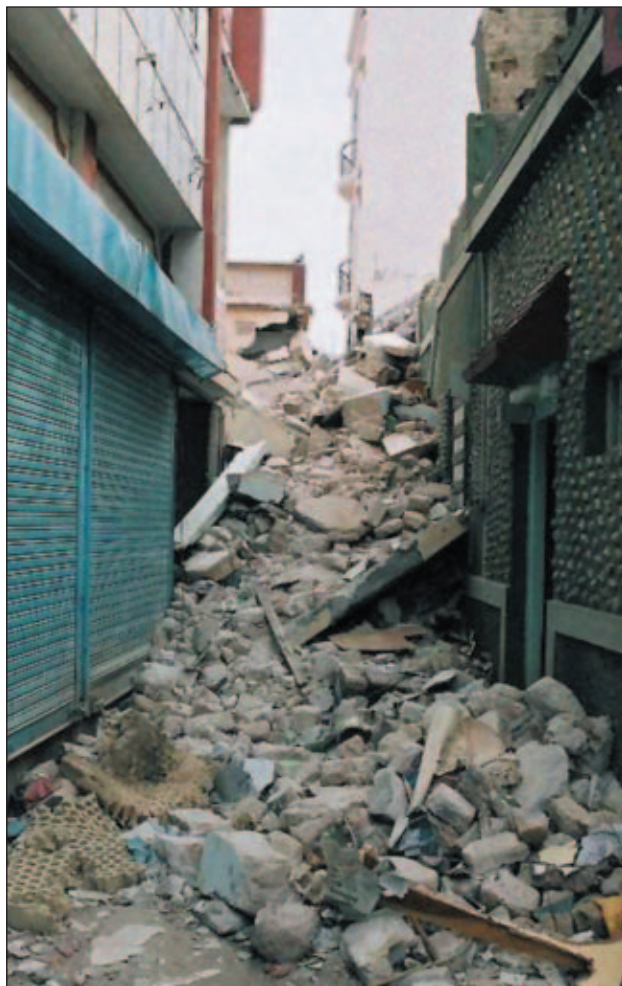
Slika 12. Andžar. Ozka ulica je zasuta z odpadnimi večjimi kosi delov porušениh zgradb.
