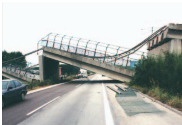
Slika 3a. Zdras mostne konstrukcije z ležišča
