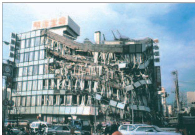
Slika 2. Porušitev zaradi močne tlorisne nesimetrije
