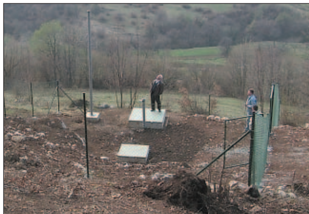
Slika 17. Dokončana potresna opazovalnica Črešnjevce pri Črneči vasi
