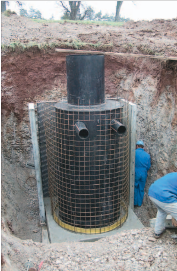
Slika 9. Sledi obbetoniranje postavljenih PHD-jaškov, v katerih bodo nameščeni instrumenti. Prikazano je stanje na lokaciji Legarje 5. 12. 2001.
