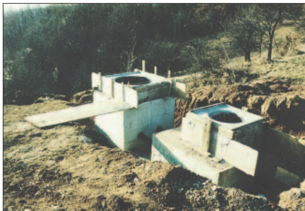
Slika 12. Stanje del na lokaciji Legarje 30. januarja 2002 (opravljena betonska dela in zasip jame, položena telekomunikacijski in energetski kabel)
