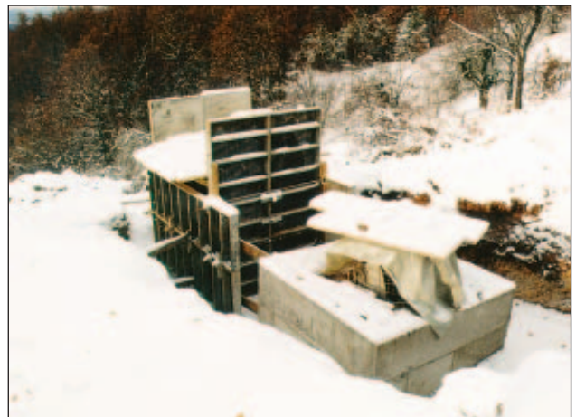
Slika 11. Stanje del na lokaciji Legarje ob prekinitvi del 14. decembra 2001 (opravljena betonska dela, onemogočeno polaganja elektroenergetskega kabla zaradi nizkih temperatur)
