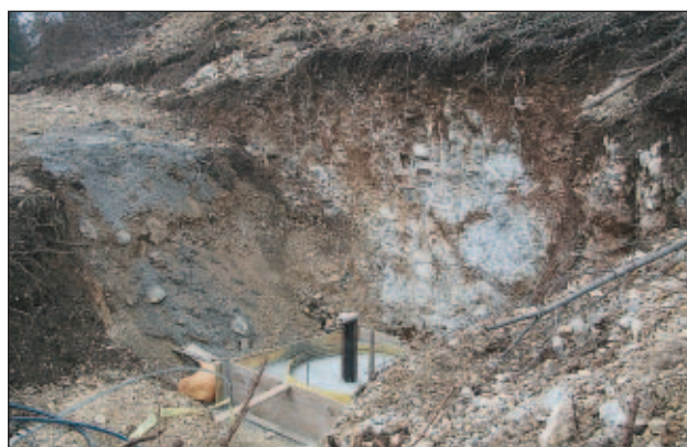
Slika 8. Naslednja faza je betoniranje podlage jaška, v katerem bodo instrumenti. Prikazano je stanje na lokaciji Goliše 5. 12. 2001.
