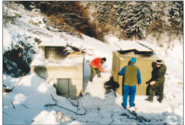
Slika 10. Stanje del na lokaciji Goliše ob prekinitvi del 14. decembra 2001 (opravljena betonska dela, onemogočeno polaganja elektroenergetskega kabla zaradi nizkih temperatur)
