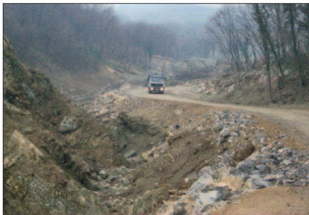
Slika 21. Retenzijski rezervni prostor za plazeče se mase, ki ščiti vas Lokavec.
