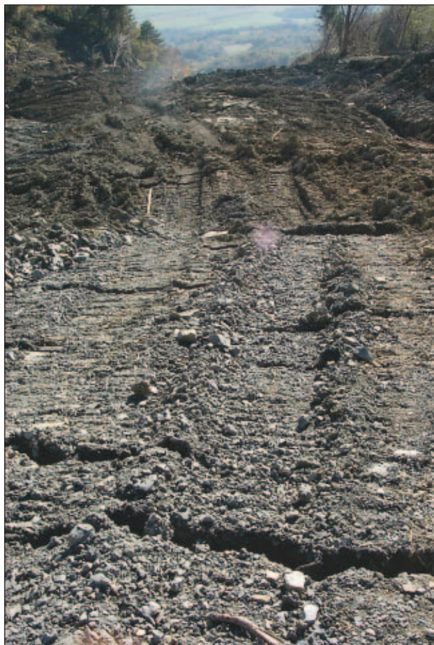
Slika 18. Zgornji kanal, do vrha zapolnjen s plazino.
