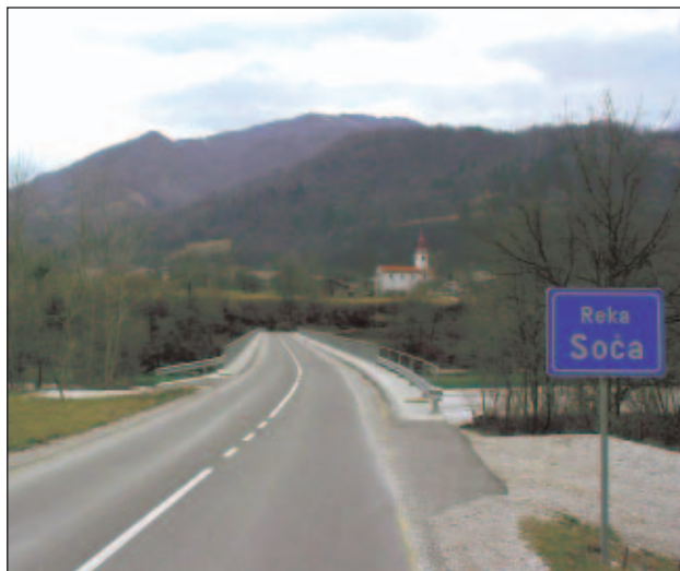
Slika 4. Obnovljeni most Kamno (foto: Z. Štanta)
