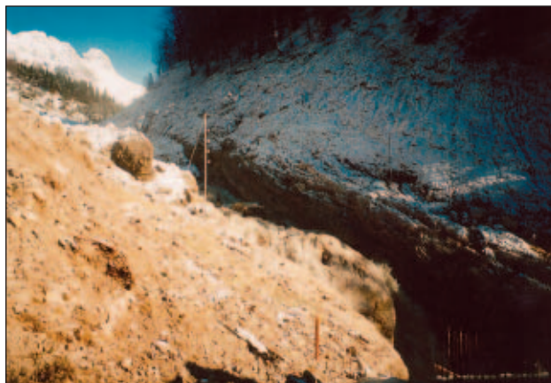
Slika 2. Mehanski alarmni sistem v Mangartskem potoku pred montažnim mostom
