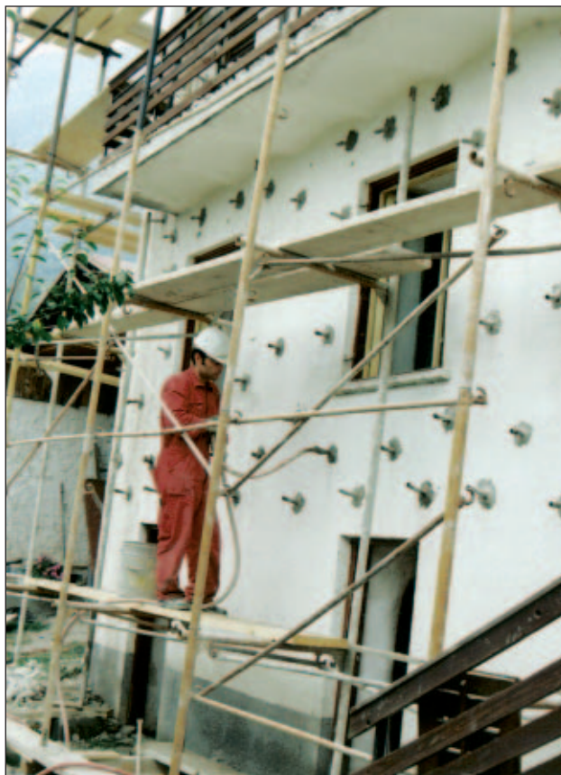
Slika 3. Detajl sistematičnega injektiranja zidov.
