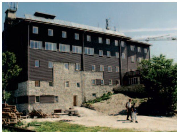
Slika 7. Ski hotel po končani obnovi – v celoti je ohranjena njegova arhitekturna podoba.
