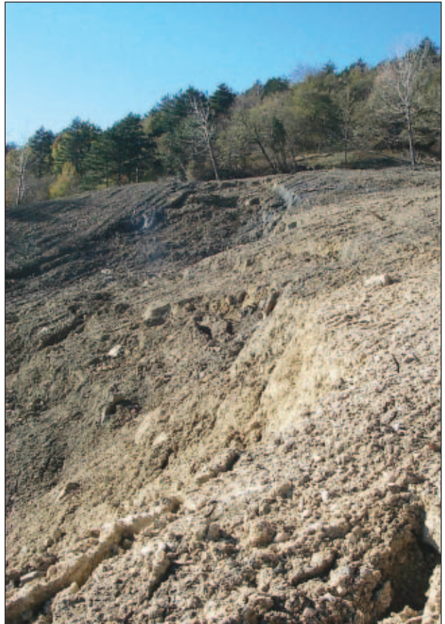
Slika 15. Nastanek lokalnega plazu na plazu Slano blato z izrazito teraso
