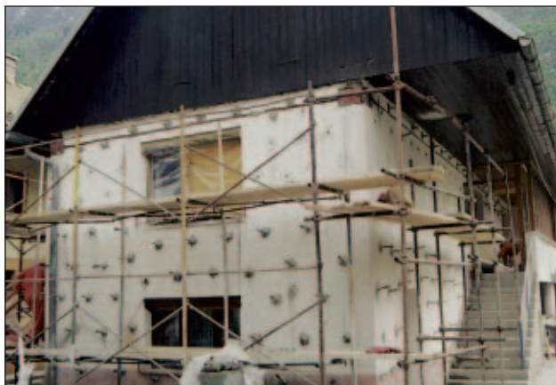
Slika 2. Povezovanje zidov z jeklenimi vezmi in sistematično injektiranje kamnitih zidov.
