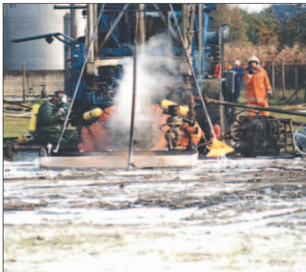
Slika 13. Zamenjava poškodovane armature na ustju vrtine (foto: arhiv UO Murska Sobota)
