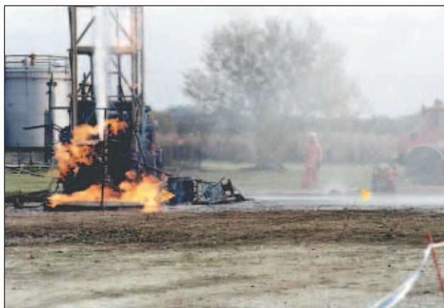
Slika 6. Pripadniki operativnih gasilskih enot širšega pomena preprečujejo širjenje požara na sosednje gradbene objekte in na zbirno postajo ZP-4 v neposredni bližini vrtine (foto: arhiv UO Murska Sobota)
