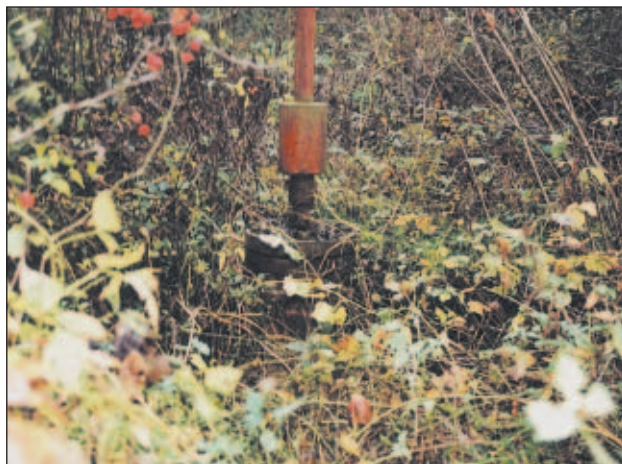
Slika 1. Opuščena, nesanirana vrtina Pg-83 na naftno-plinskem polju Petišovci–Globoko (foto: M. Smodiš)
