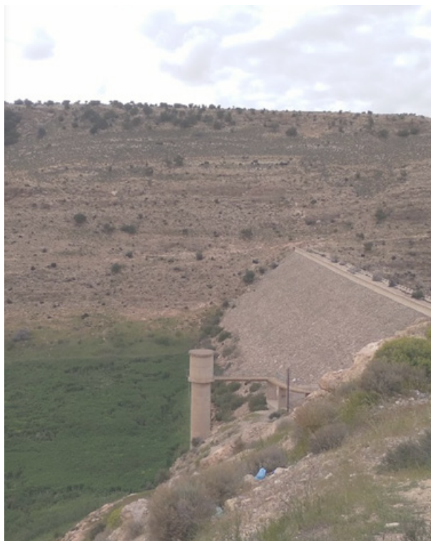
Slika 5: Zgornja severna pregrada Bu Mansur pred porušitvijo (vir: Google Earth)
