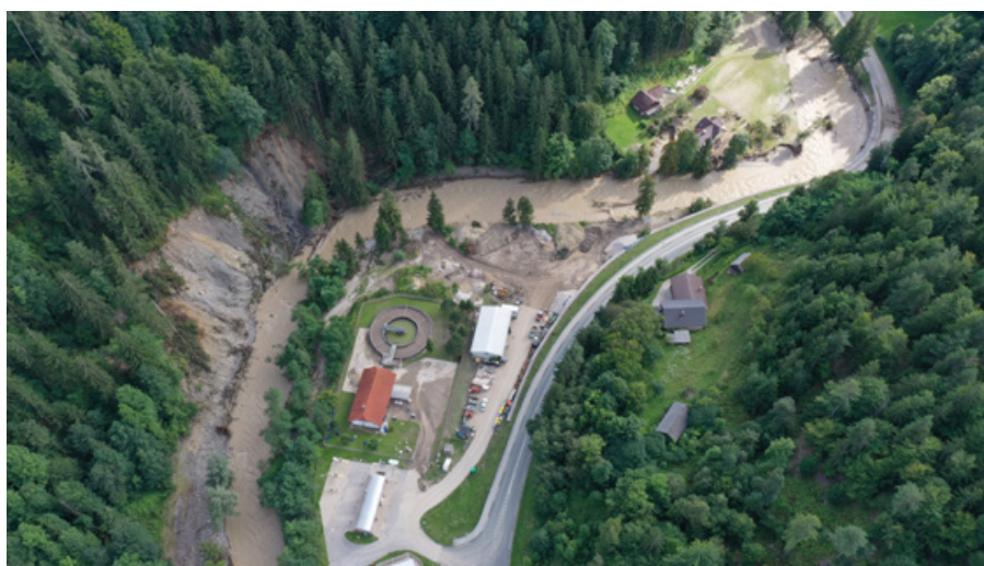
Slika 4: Pregled širše lokacije – gospodarsko območje Vogarjevo (foto: CZ Mežica)
