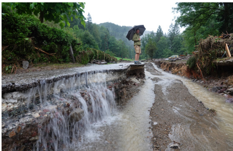
Slika 2: Povsem uničena cesta v Bodoljski grapi (foto: D. Slabe)
