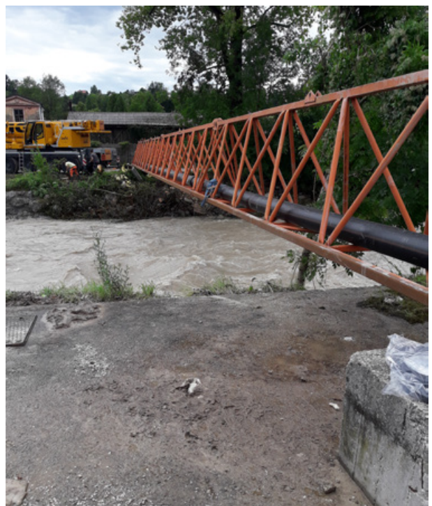
Slika 6: Začasna sanacija primarnega vodovoda (foto: Komunalno podjetje Kamnik, d. o. o.)
