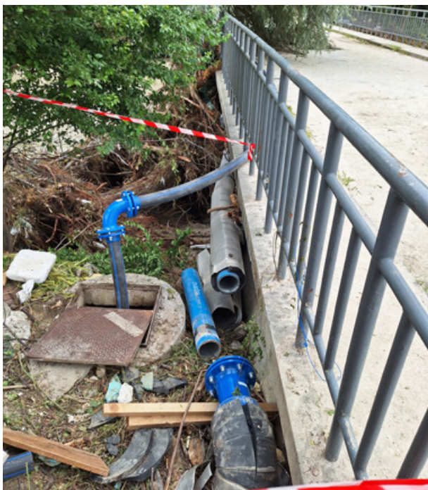
Slika 7: Začasna sanacija vodovoda na mostu (foto: Komunalno podjetje Kamnik, d. o. o.)
