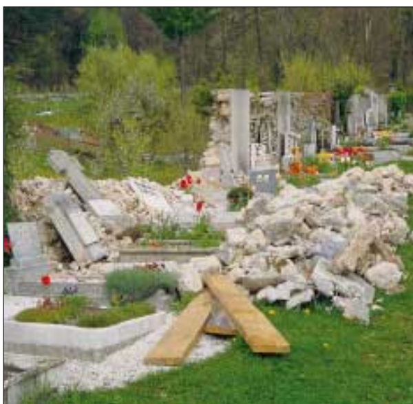
Slika 10. Razdejano pokopališče v Bovcu (poškodba 4. stopnje) (foto: R. Vidrih) Figure 10. Heavily damaged graveyards at Bovec (grade-4 damage) (photo: R. Vidrih)
