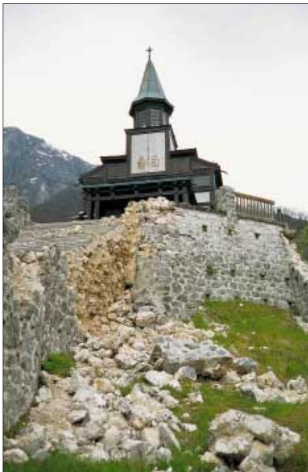
Slika 6. Podrti podporni zidovi na Javorci, lesena cerkev pa je vzdržala brez poškodb (poškodbe 2. do 3. stopnje) (foto: R. Vidrih)
