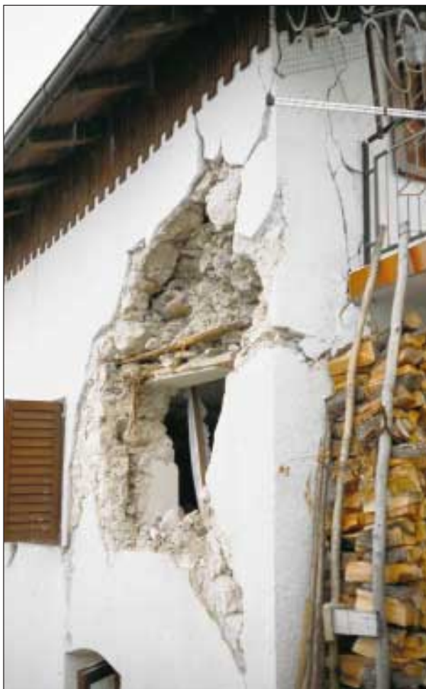
Slika 11. Uničena hiša v Spodnjih Drežniških Ravnah (poškodba 5. stopnje) (foto: R. Vidrih) Figure 11. Destroyed house in Spodnje Drežniške Ravne (grade-5 damage). (photo: R. Vidrih)
