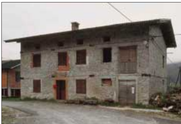
Slika 5. Smast: hiša, ki je bila ustrezno utrjena po letu 1976, po potresu leta 1998 ni bila poškodovana (foto: M. Tomažević)
