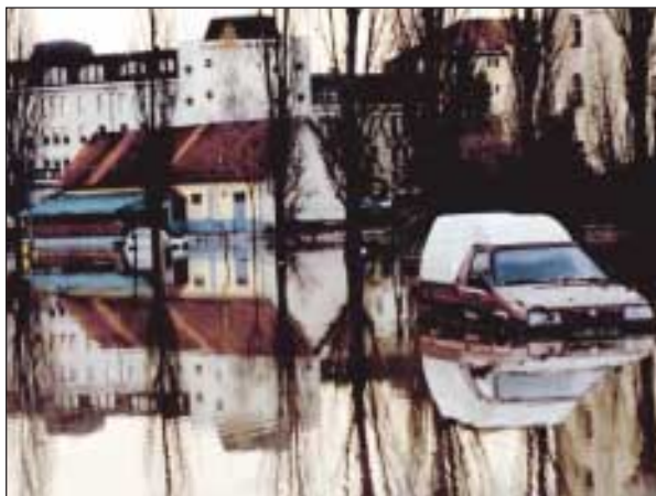
Slika 15. Povodenj v Celju 5. novembra 1998 (foto: J. Uhan) Figure 15. Flood in Celje on 5 November, 1998 (photo: J. Uhan)
