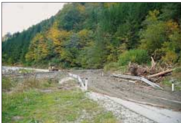
Slika 1. Pritok Zadnje Sore izpod Bidržne: ogromne količine plavin so zatrpale prepust in zasule cesto – neurje oktobra 1998 v Selški dolini (foto: A. Klabus)
