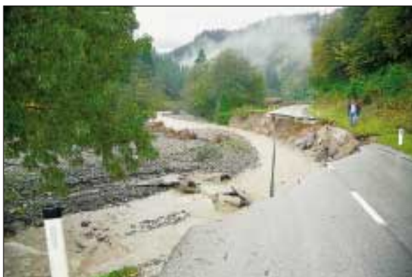
Slika 4. Selška Sora v Podroštu: zaradi nezavarovane konkavne brežine je odneslo novo cesto – neurje oktobra 1998 v Selški dolini (foto: A. Klabus)
