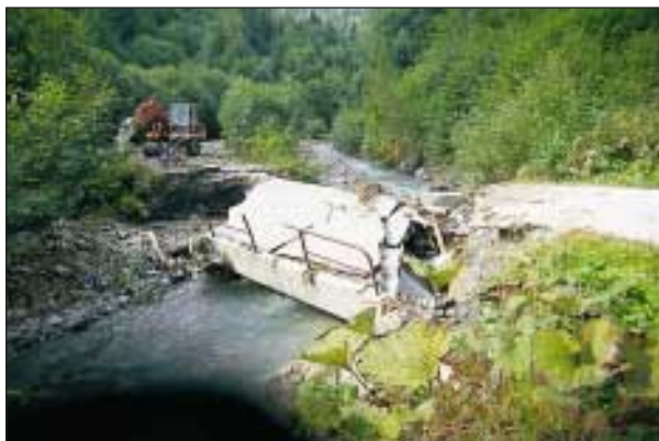
Slika 2. Davča v Zgornji Davči: neurejenost struge in nestabiliziranje dna sta uničili most – neurje septembra 1995 v Selški dolini (foto: A. Klabus)
