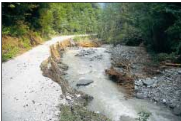
Slika 5. Zadnja Sora: posledice neustreznega zavarovanega cestnega nasipa in neustaljenega dna struge – neurje septembra 1995 v Selški dolini (foto: A. Klabus)
