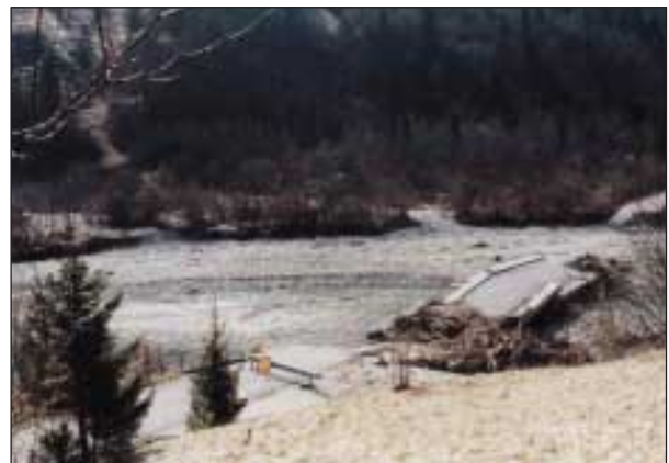
Slika 1. Pogled na zrušeni most in odneseni del ceste z višine okoli 10 m nad niveleto ceste oz. prvotno niveleto mostu. Slika kaže most pod ostrim kotom z njegove gorvodne strani. V sredi slike se jasno vidi desno korito od dveh sekundarnih matic deroče vode. V ozadju je manjkajoči del cestnega telesa. Prelom vozišča je nad desnim srednjim podpornikom. (foto: S. Trček)
