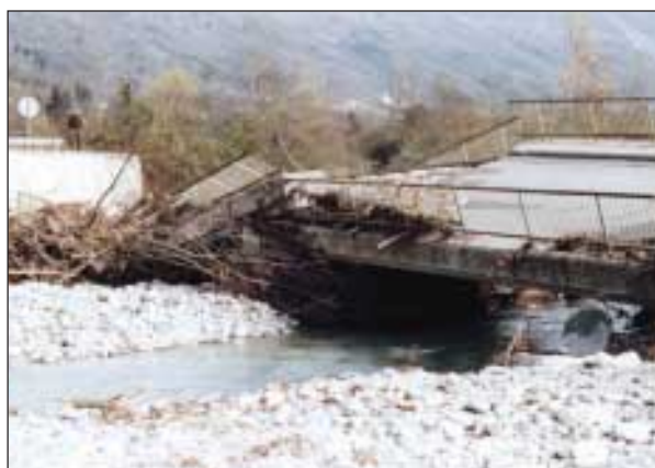
Slika 6. Pogled z gorvodne strani na desni srednji podpornik: vidi se desni konec prefabriciranih nosilnih gred z nekakšno sidrno armaturo (foto: J. Eržen)
