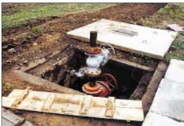
Slika 13. Sanacija opuščene vrtni Fi-5 v Filovcih (foto: M. Smodiš) Figure 13. Rehabilitation of abandoned Fi-5 well in Filovcih (photo: M. Smodiš)
