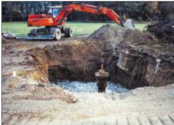
Slika 14. Potek gradbenih del pri sanaciji opuščene vrtni Fi-14 v Beltincih (foto: M. Smodiš) Figure 14. Rehabilitation works on the abandoned Fi-14 well in Beltinci (photo: M. Smodiš)
