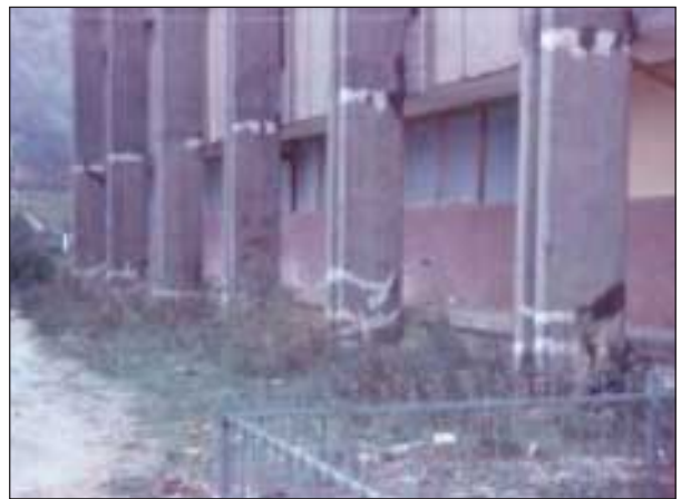
Slika 3. Konstrukcija stavbe občine v Ulcinju po sanaciji poškodb (foto: P. Fajfar) Figure 3. The structure of the Communal Assembly in Ulcinj after repair (photo: P. Fajfar)
