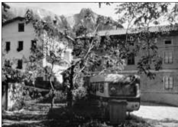
Slika 2. Jezerca (Drežniško) – posamične postavitve začasnih bivališč v neposredni bližini poškodovanih stavb (foto: S. Dalla Valle) Figure 2. Jezerca (Drežniško) – individual temporary homes close to damaged houses. (photo: S. Dalla Valle)
