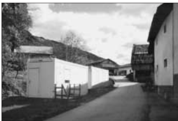
Slika 3. Drežnica – posamične postavitve zabojnikov v bližini poškodovane stavbe (foto: S. Dalla Valle) Figure 3. Drežnica – individual containers positioned near damaged houses. (photo: S. Dalla Valle)
