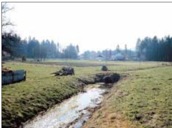
Slika 3. Homšnica dolvodno od hiše Mislinjska Dobrava 41 – neustrezen cevni prepust (foto: Z. Fujs) Figure 3. The Homšnica downstream from Mislinjska Dobrava 41 – unsuitable pipe passage (photo: Z. Fujs)
