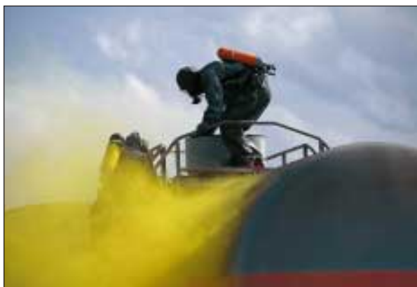
Slika 1. Uhajanje klora iz cisterne (foto: J. Oražem) Figure 1. Chlorine leakage from a tanker (photo: J. Oražem)
