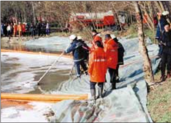
Slika 12. Odstranjevanje zajete nevarne snovi – imitacijskega sredstva CONEX WB1 – z gladine Mure v zbiralne bazene (foto: S. Jauk)
