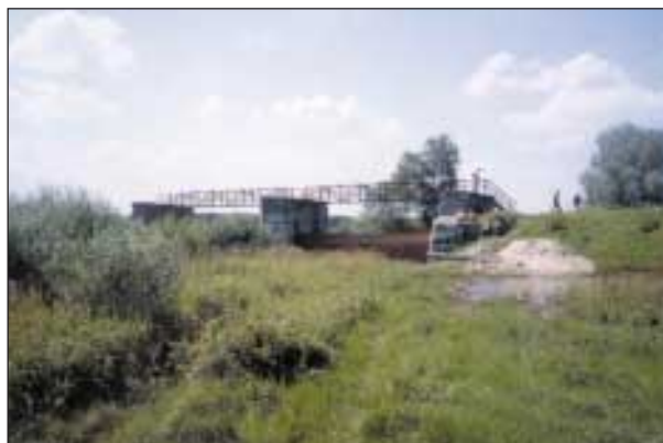
Slika 2. Vhodna zapornica v zadrževalnik Stobrawa-Rybna (foto: S. Kušar) Figure 2. The entrance gate to the Stobrawa-Rybna polder (photo: S. Kušar)
