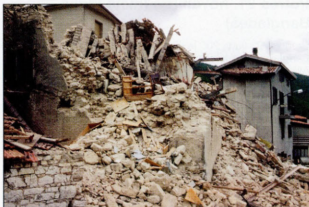
Slika 4. Porušena stanovanjska hiša v vasi Aggi (foto: M. Godec)
