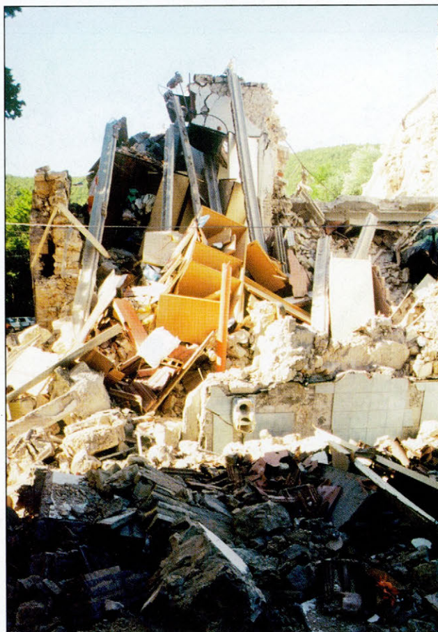
Slika 3. Pogled na porušen objekt v vasi Casenove, v katerem je bila policijska postaja in pošta (foto: M. Godec) Figure 3. Close view of demolished police station and post office in Casenove (photo: M. Godec)
