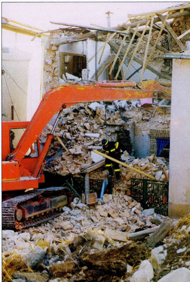
Slika 14. Gasilci rešujejo predmete iz hiše v vasi Arvello; zaradi hudih poškodb so hišo morali podreti, da ne bi dodatno poškodovala sosednjih objektov.
