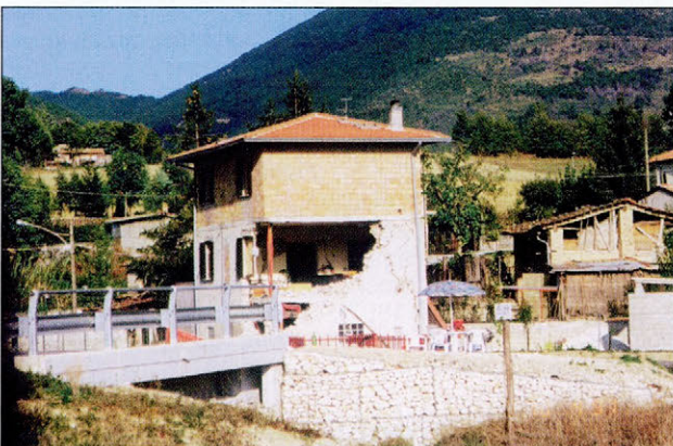
Slika 7. Hiša v vasi Le Moline je tipičen primer poškodb, ki nastanejo, ko na slabem in neojačanem objektu nadzidajo nadstropje s težko streho.
