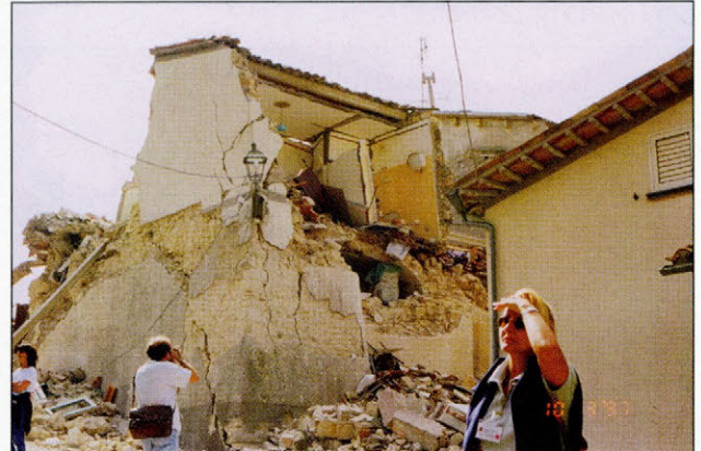
Slika 5. Collecureti, ruševine velike starejše družinske hiše na levi in nepoškodovana obnovljena hiša na desni strani ulice
