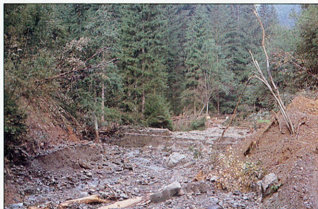
Slika 3. Postavitev ceste ob potokih je lahko včasih za cesto usodna. Hud naliv je v Rihtarjevem grabnu na Koroškem avgusta 1995 odplaval gozdno cesto v vsej dolžini (foto: J. Beguš)
