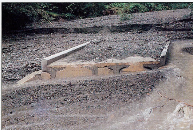
Slika 2. Konstrukcija je vodno stihijo preživela, vendar pa so nanosi materiala most praktično zatrpali – Rihtarjev graben avgusta 1995 (foto: J. Beguš)
