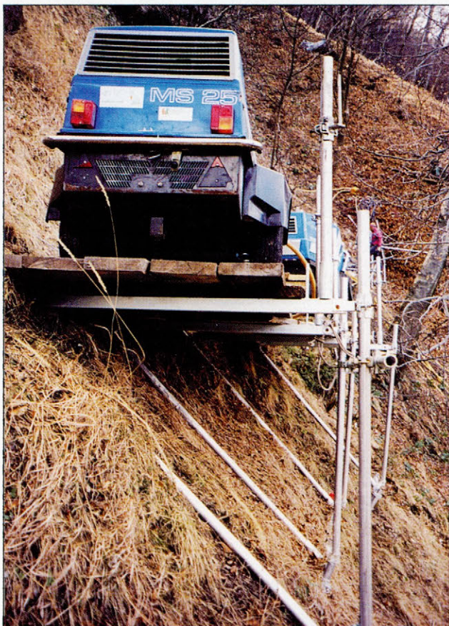
Slika 4. Drča II – namestitvev kompresorjev (foto: D. Durjava) Figure 4. Installation of compressors (photo: D. Durjava)
