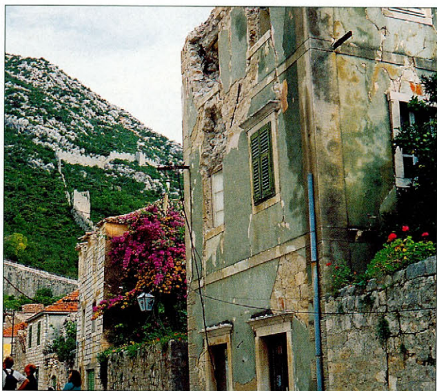
Slika 4. Ulice v Stonu so si bile po potresu podobne. Povsod so ležale opeke in deli zidov porušenih zgradb. Mestno jedro je bilo zaradi nevarnosti podirajočih se zidov zaprto (foto: R. Vidrih)
