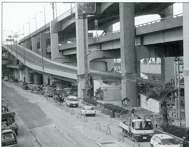
Slika 2. Popravljeni stebri in izvoz dvignjene avtomobilske ceste, ki povezuje mesto z otokom Portopia (foto: J. Lapajne in M. Godec)
