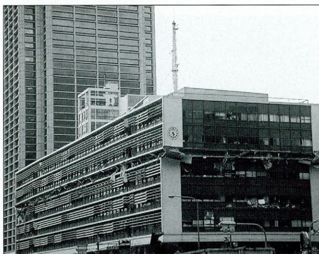
Slika 8. Del stavbe nad sesedenim nadstropjem so odstranili in ponovno zgradili (foto: J. Lapajne in M. Godec)
