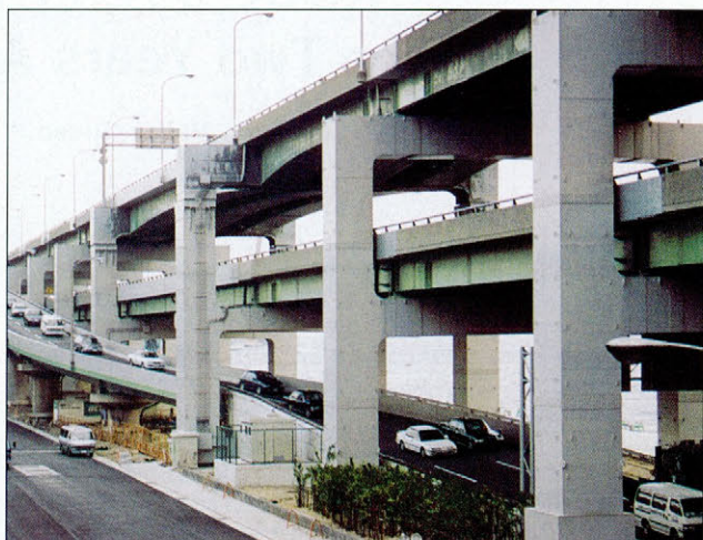
Slika 2. Popravljeni stebri in izvoz dvignjene avtomobilske ceste, ki povezuje mesto z otokom Portopia (foto: J. Lapajne in M. Godec)
