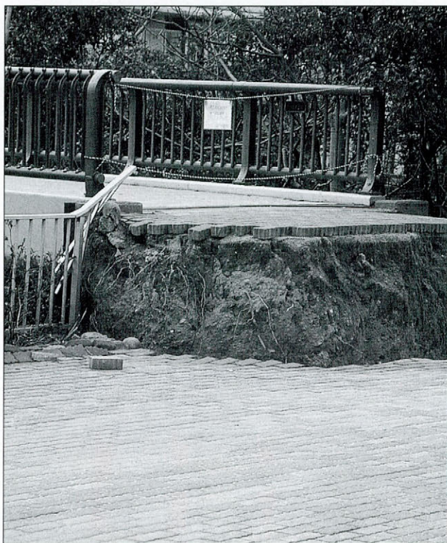
Slika 11. Obnova velikega posedka ob mostu (foto: J. Lapajne in M. Godec)
