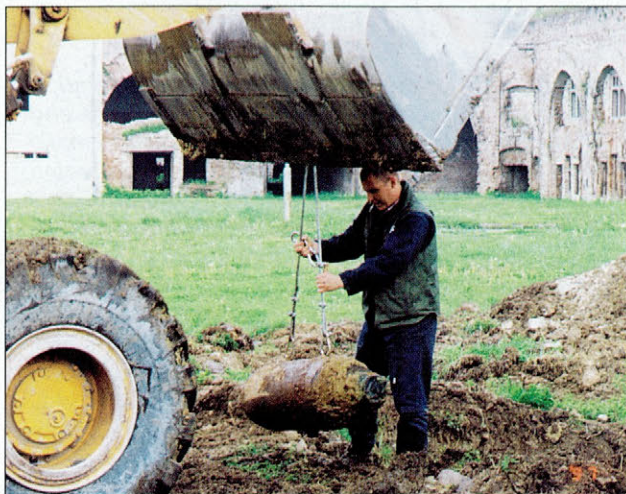
Slika 1. Odstranjevanje letalske bombe 500 lb ameriške izdelave iz II. svetovne vojne iz trdnjave v Slavonskem Brodu (spomenik ničte kategorije): projektil je bil najden s pomočjo računalniškega globinskega detektorja znamke Valone s programom EVA, izkopan, odpeljan in uničen Figure 1. Removal of an American-made, 500 lb - aircraft bomb from World War II, from the Slavonski Brod Fortress (a zero-category monument); the projectile was found by means of a Valone computer-aided depth detector (Programme EVA), and has been excavated, taken away and destroyed.
