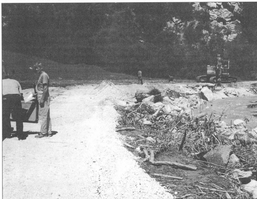
Slika 2. Obnovitvena dela porušenega cestnega odseka v dolini Velunje po visoki vodi 9. 8. 1995 (foto: Janez Polajnar) Figure 2. Reconstruction of ruined road in Velunja valley after high water 9. 8. 1995 (photo: Janez Polajnar)
