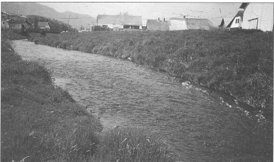
Slika 9. Regulirani bregovi Dravinje omogočajo hiter odtok vode (Dražva vas) (foto: A. Vovk)
