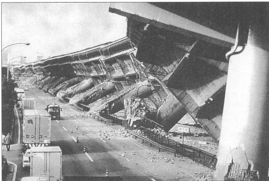
Slika 5. Poleg požarov lesenih hiš je bilo najhujše na avtomobilskih cestah; primer cestišča, ki je bilo na enojnih konzolnih stebrih: podrla se ga je 365 metrov, 17 konzol se je porušilo na mestu prekinitve vzdolžne armature (foto: Architectural Institute of Japan)
