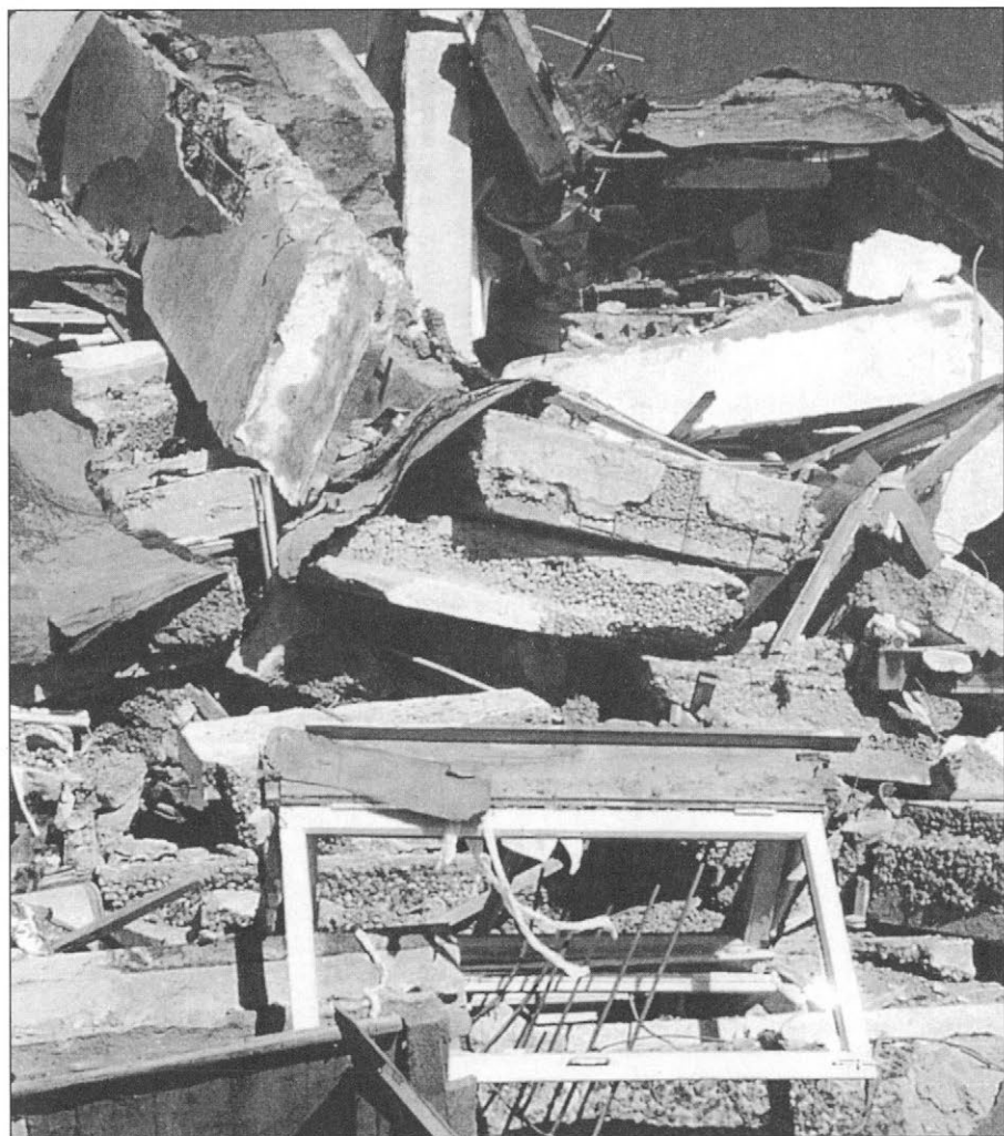
Slika 7. Uničen petnadstropni blok brez sleherne protipotresne zaščite (foto: G. L. Koff z moskovskega inštituta za litosfero; posnetek je za objavo posredoval M. Tomaževič)
