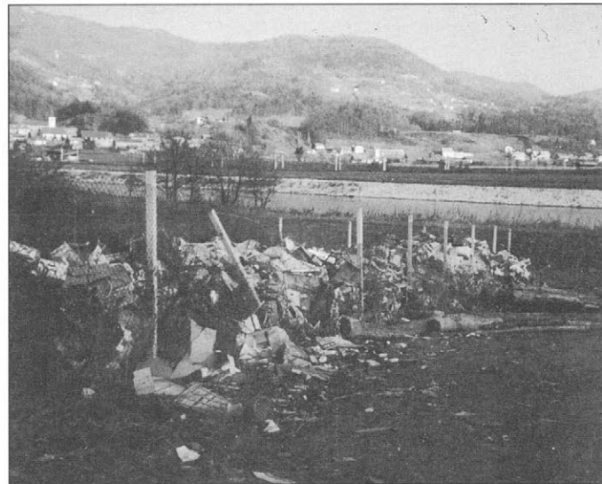
Slika 6. Odlagališče Radeče občasno poplavlja visoke vode reke Save (foto: A. Petkovšek) Figure 6. The Radeče landfill is periodically flooded by the high waters of the Sava River (photo: A. Petkovšek)
