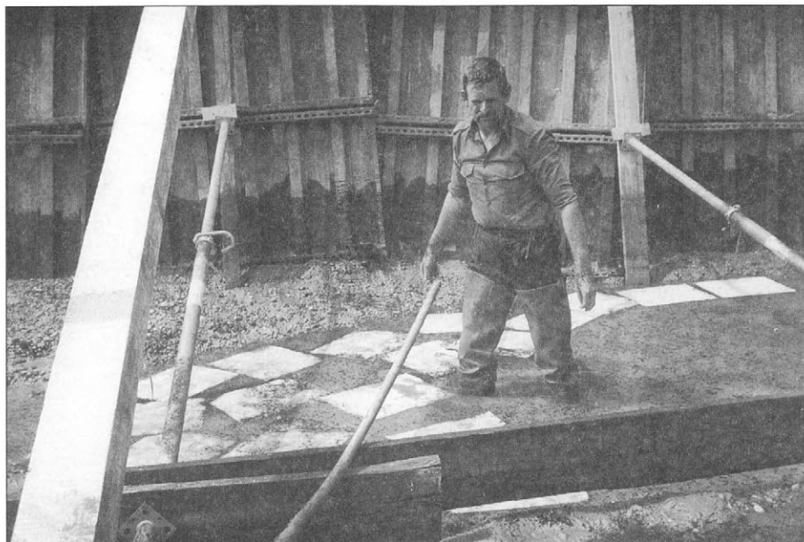
Slika 2. Gasilec polaga absorpcijske krpe na podtalnico, vidni so tudi madeži derivatov (foto: J. Bošnjak)
