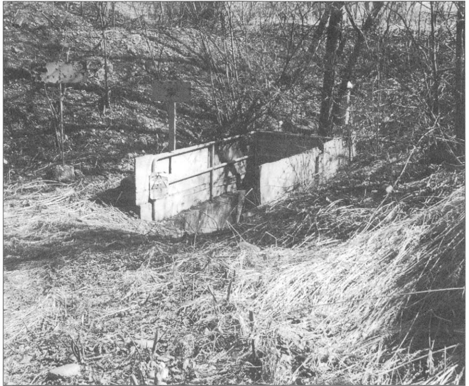
Slika 4. Podzemni bunker za skladiščenje radiografskih virov Figure 4. Underground bunker for storage of radiographic sources
