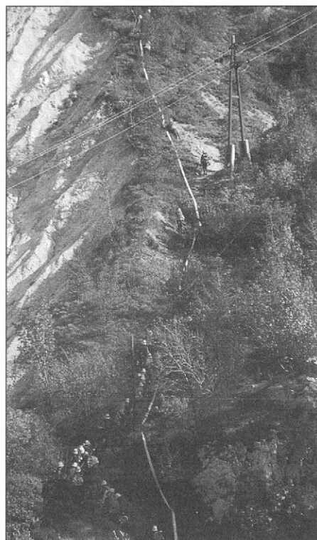
Slika 1. Postavljanje verižnega sistema za zagotavljanje požarne vode (foto: arhiv Uprave RS za zaščito in reševanje)
